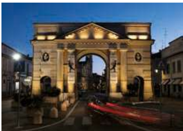
LA NUOVA ILLUMINAZIONE PER LA MONUMENTALE PORTA OMBRIANO A CREMA, ACCESSO AL CENTRO STORICO DELLA CITTÀ LOMBARDA
