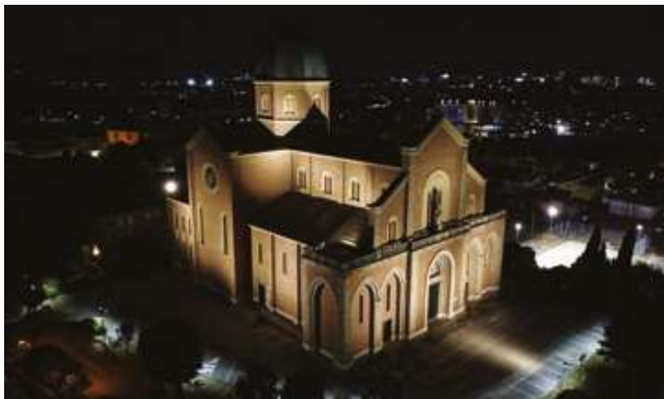
IL COMUNE DI MONTEGROTTI TERME, IN PROVINCIA DI PADOVA, PROTAGONISTA DI UN IMPORTANTE INTERVENTO DI EFFICIENTAMENTO E RIQUALIFICAZIONE DEGLI IMPIANTI DI ILLUMINAZIONE PUBBLICA
